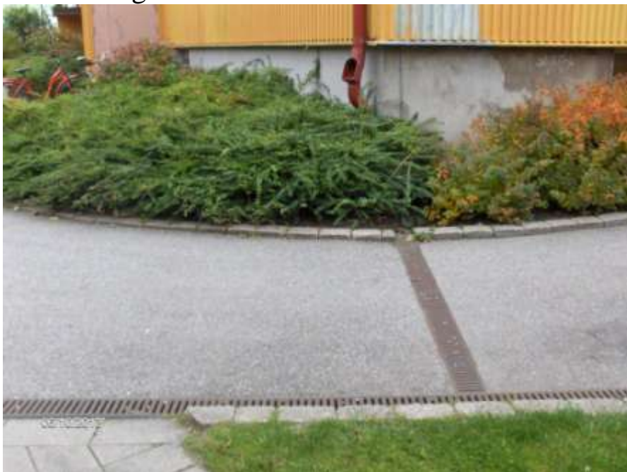
6. Bortledning i kanal med rist over.
