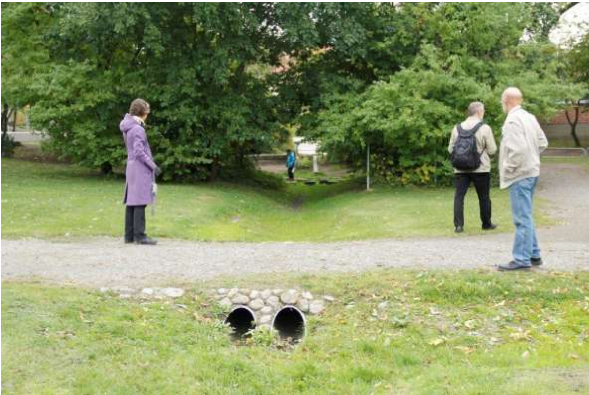
27. Rørføring under sti (overgang).
