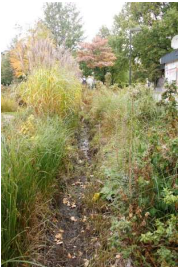
15. Regnbed med kraftig bevoksning så det næsten er skjult set fra siden.
