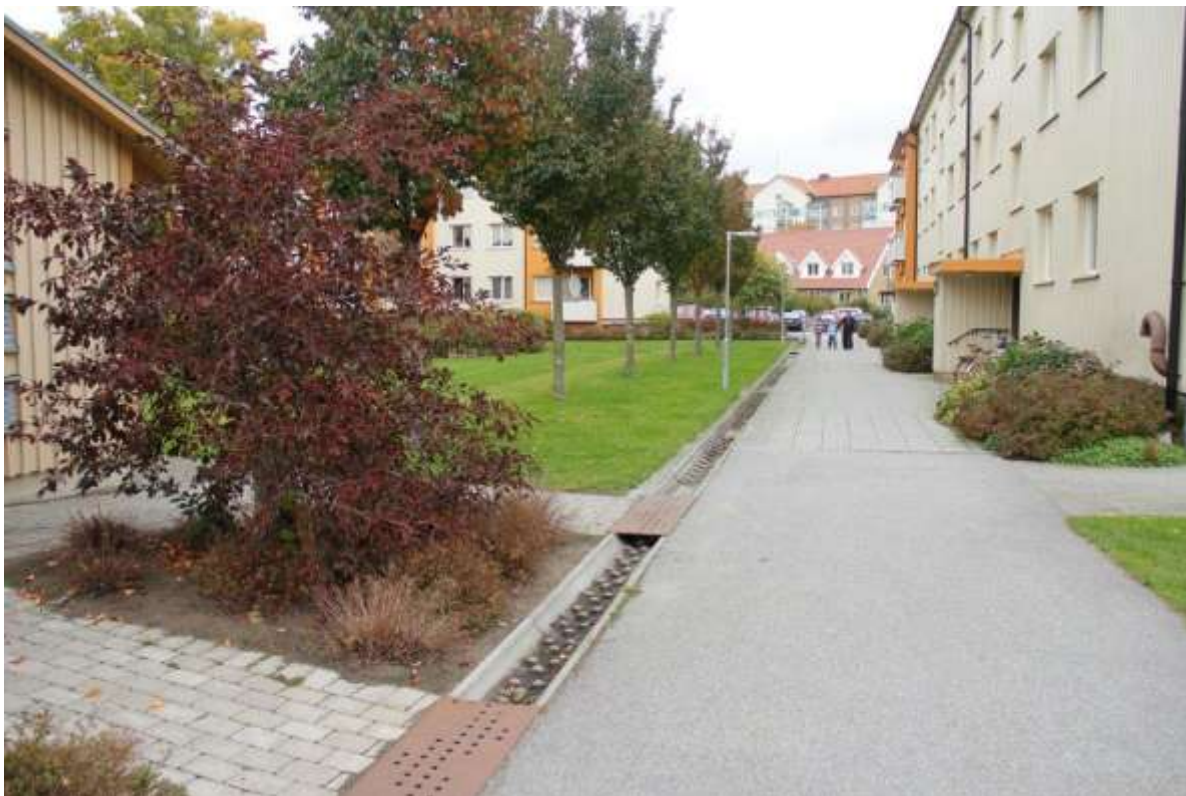
26. Overgang udført af jernplader. Se i øvrigt tidligere billeder.
