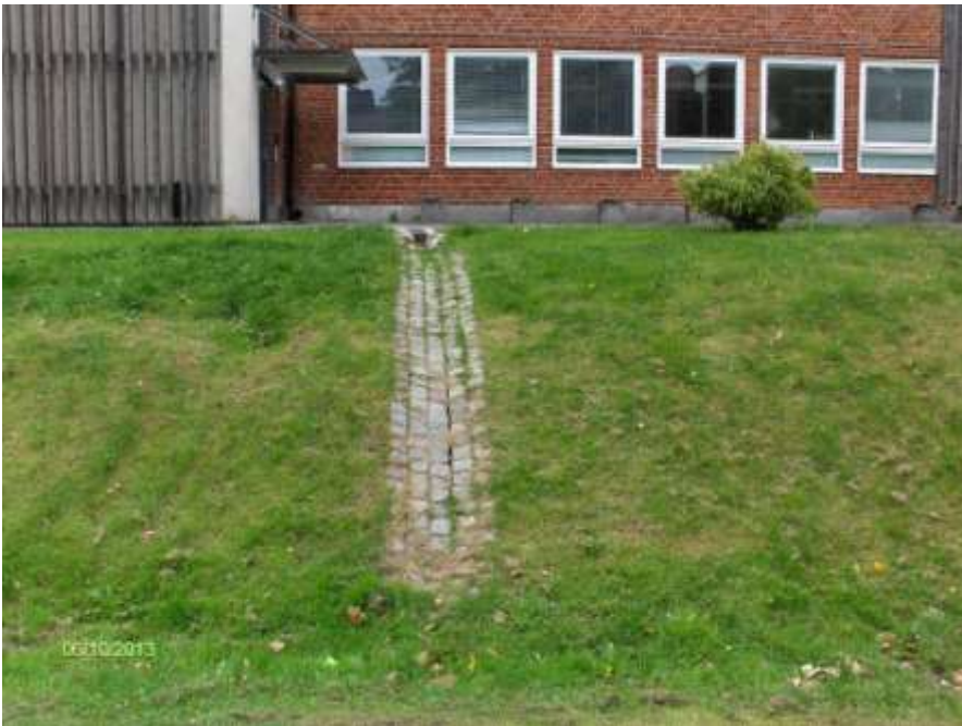
13. Fra kanal ledes vandet ned over skrænten og i ned over græsset hvorfra det nedsiver.
