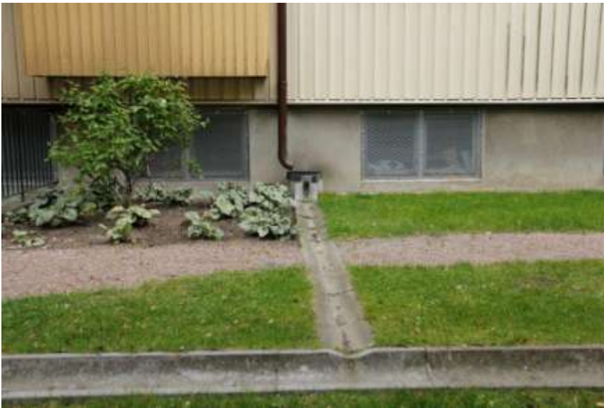
3 Betonstøbt vandfang med metalskinne monteret efterfølgende for at forhindre at vandet sprøjter ud på jorden.
