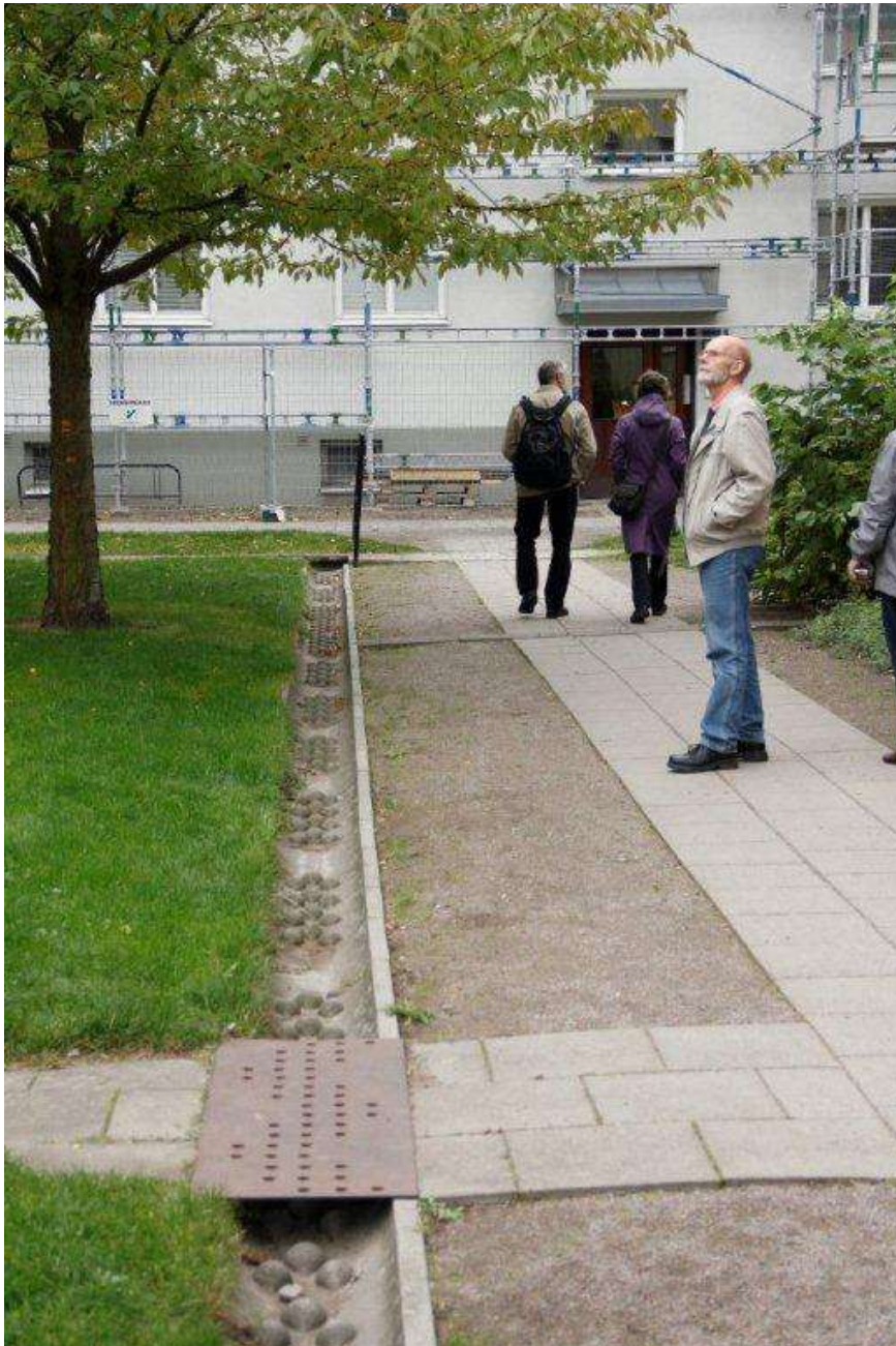
10. Bortledning i betonstøbt kanal. Metalplade brugt som lille bro hvor stien krydser kanalen
