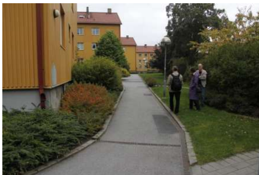
7. Bortledning i kanal med rist over.
