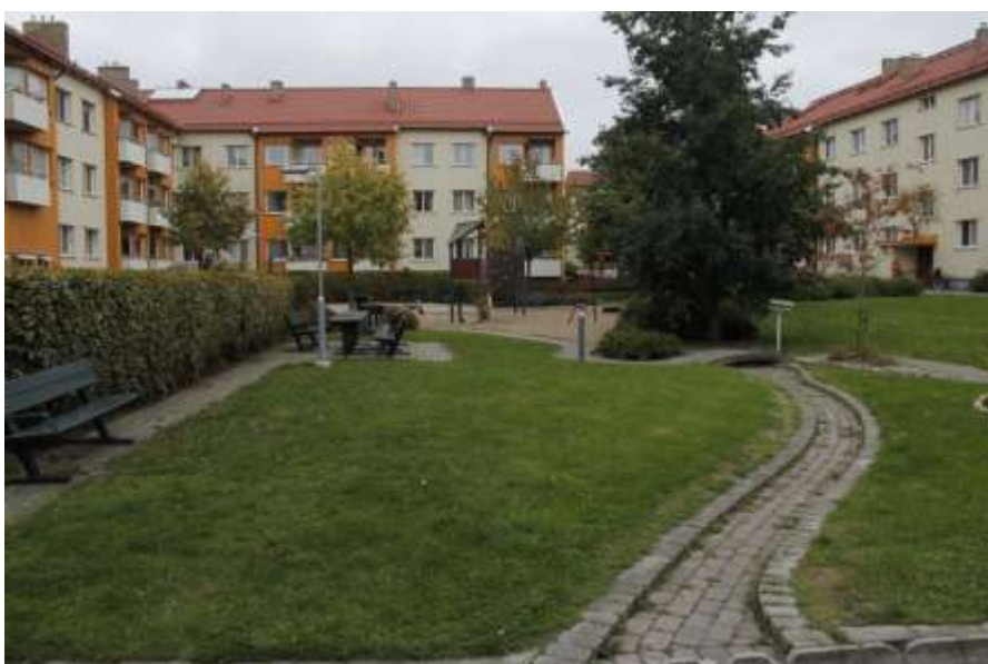
8. Bortledning i åben flad kanal. Nedsivning mellem brostenene. Lille bro i baggrunden.
