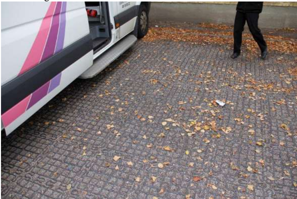
25. Befæstning OG nedsivning. Eneste eksempel vi så på turen, men der findes mange typer der har samme funktion.
