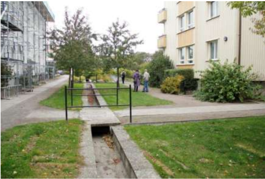
11. Større kanal og bro med gelænder.
