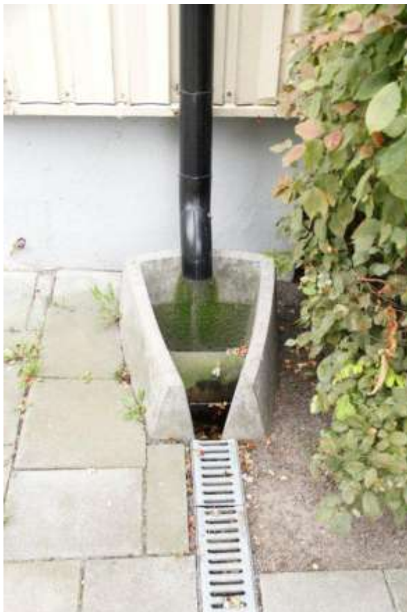
1. Betonstøbt vandfang og bortledning i lille kanal med rist.
