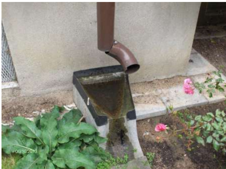
2. Betonstøbt vandfang med metalskinne monteret efterfølgende for at forhindre at vandet sprøjter ud på jorden.
