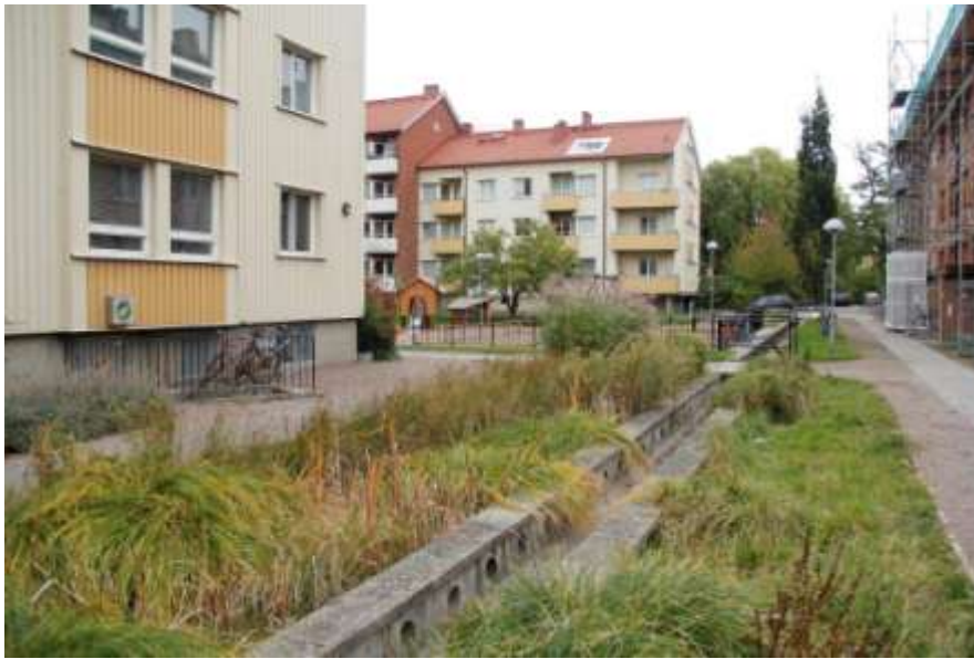
9. Bortledning og regnbed. Når vandstanden i regnbedet stiger over et vist niveau løber det gennem hullerne til den betonstøbte kanal og bortledes (eller også var det omvendt).
