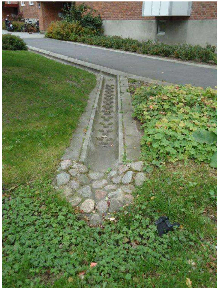
1. Fra kanalen ledes vandet ud over græsområdet hvor det nedsiver.
