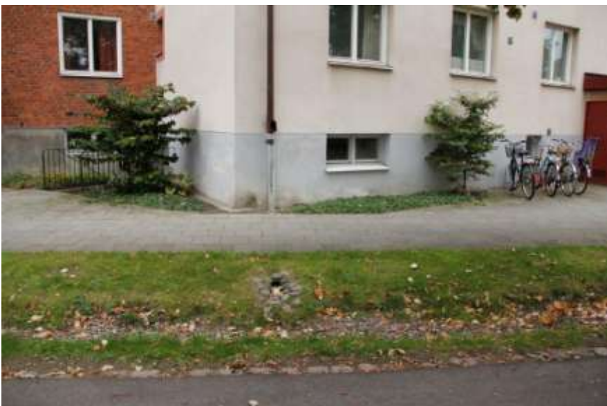
5 Nedløbet fortsætter direkte ned under jordniveau og videre under sti til lille kanal med nedsivning
