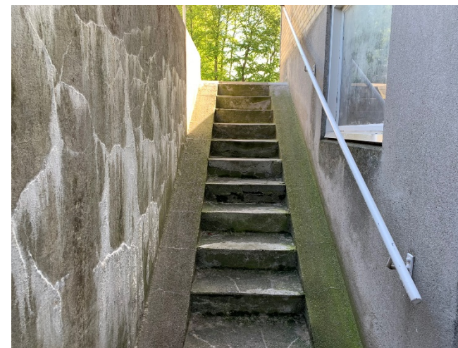
De udvendige kældertrapper fremstår flere steder med revnedannelser og afskalninger i trapper og vanger.
