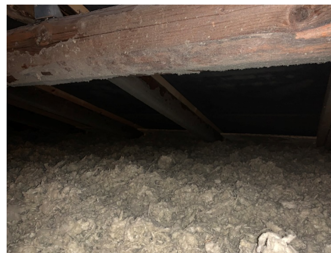
Etageskilnelser mod loft er isoleret med mineraluldsgrenulat
