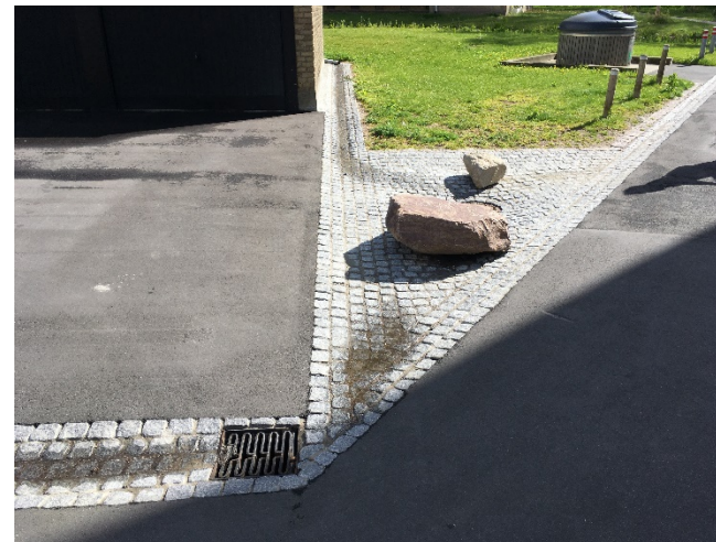
Overfladeafvand ledes via åbne kanaler til render i terræn, hvor det nedsiver
