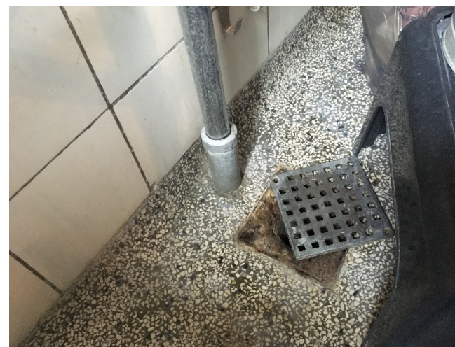
Oprindeligt gulv afløb i badeværelse
