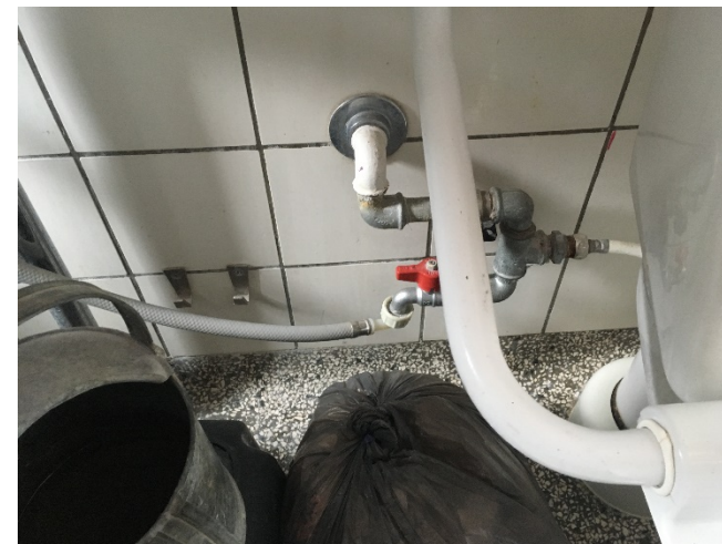
Rørgennemføring i væg med afgrening til tapsteder
