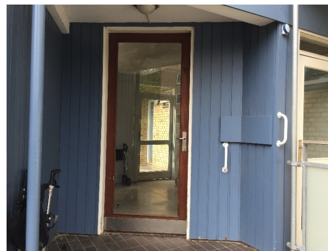
Opgangsdør er ældre trædør med 1 lag glas
