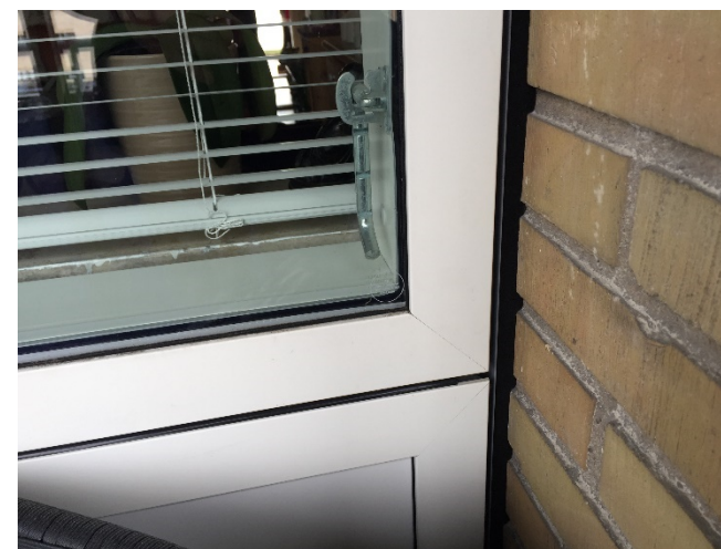
Vinduer er tætnet med fugebånd
