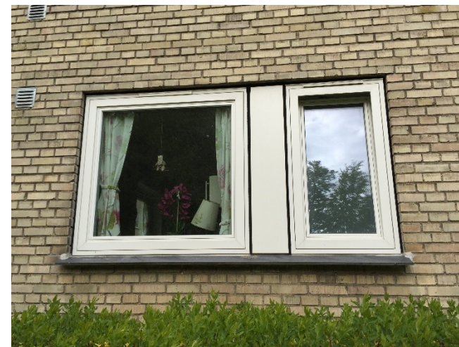
Vinduer er af samme type og opbygning på de tre blokke
