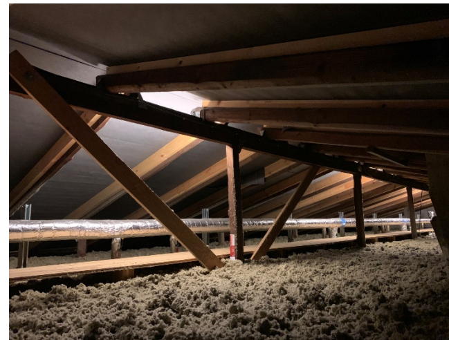
Taget er udskiftet ifm. et større renoveringsprojekt i 2012/2013
