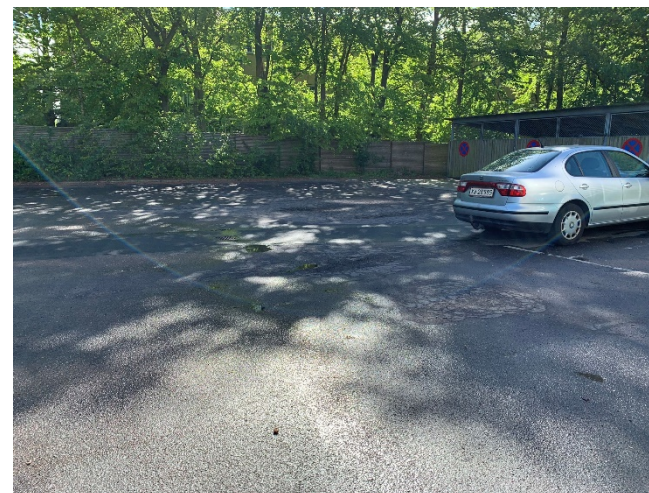
Belægninger på parkeringsplads fremstår med revner og huller
