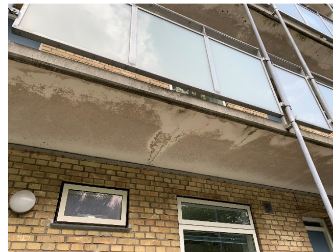
Afskalninger på underside af svalegang
