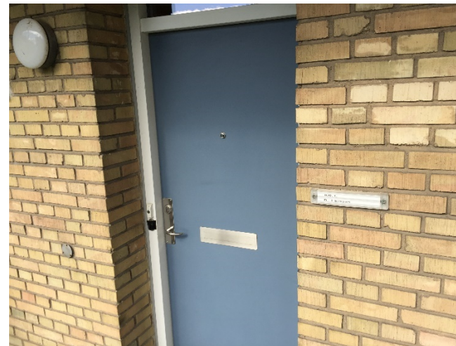
Lejlighedsdøre er placeret ved svalegang
