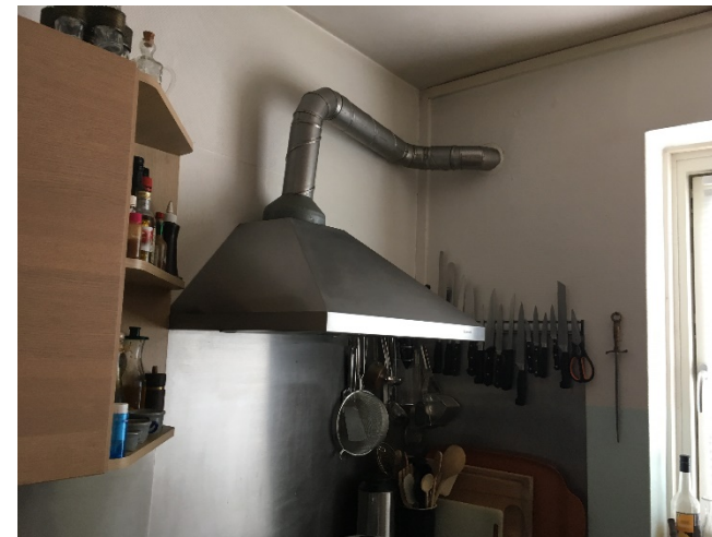
Eksempel på emhætte tilsluttet afkast i ydervæg
