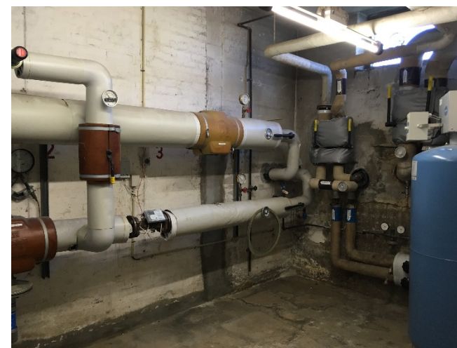
Fjernvarmetilslutning i varmecentral i Blok 9
