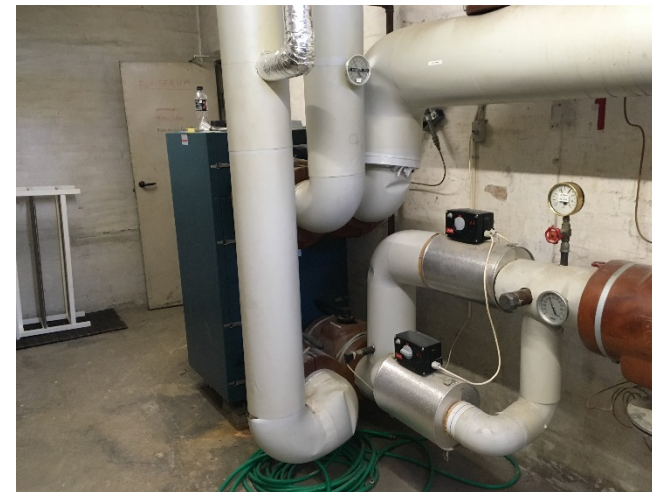
Varmveksler i varmecentral Blok 9
