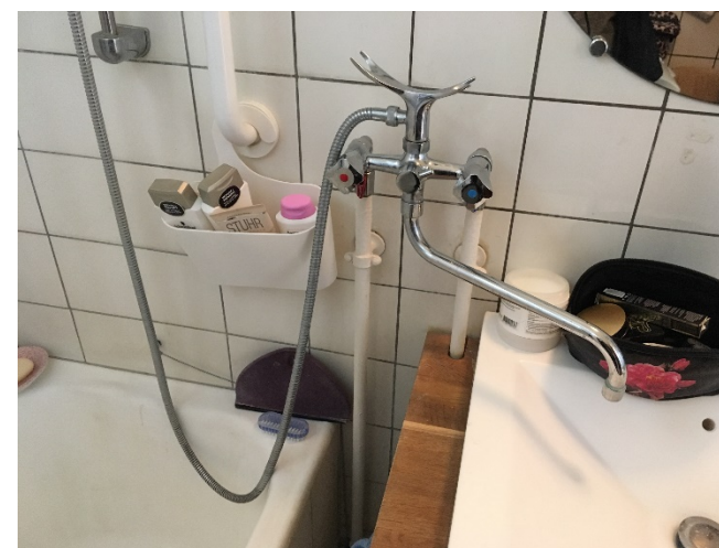
Synlig tilslutning til armatur ved håndvask og bruser
