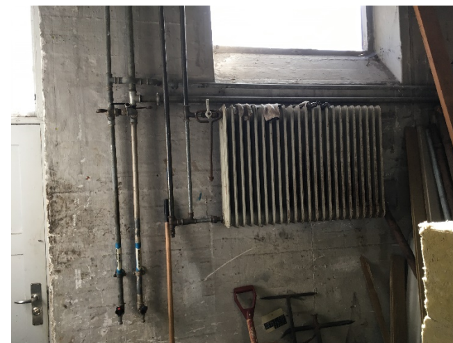
Radiator i kælder
