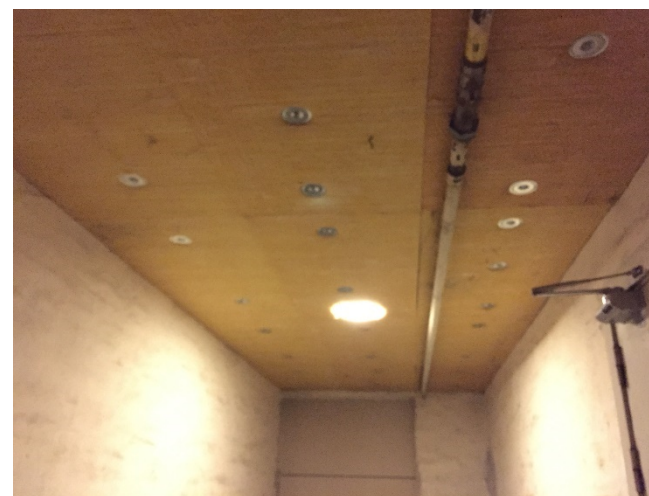
Der ses at være foretaget delvis efterisolering af lofter
