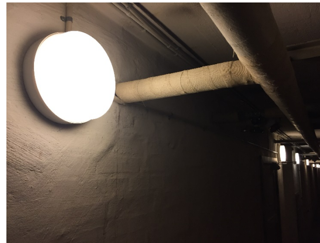
Belysning i kælder styres med sensor
