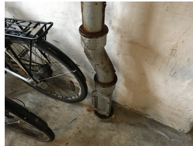
Tæret faldstamme i kælder med renselem
