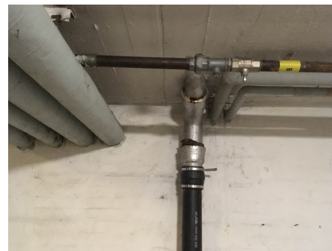
Eksempel på faldstamme i kælder, der er repareret og i dårlig stand
