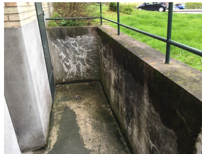
Vanger og bund i udvendig kældertrappe
