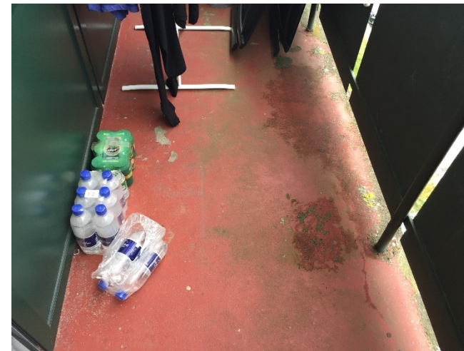
Nedbrudt membran på altan på blok 1
