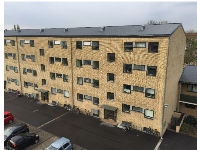
Tagene er beklædt med tagdækning af stålplader
