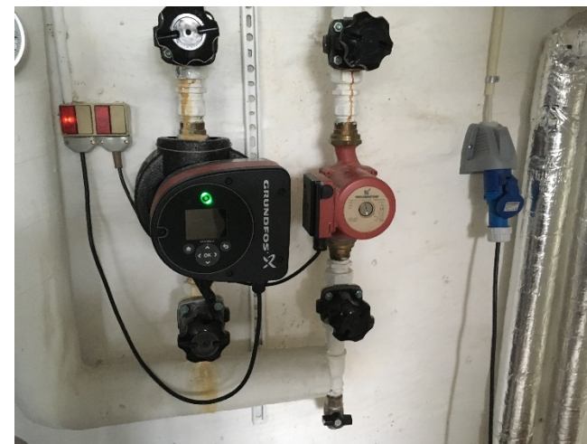
Pumper til cirkulation af varmt brugsvand. Den lille pumpe fungerer som reservepumpe
