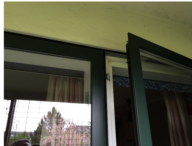
Vinduer er tætnet med fugebånd af typen illmodbånd
