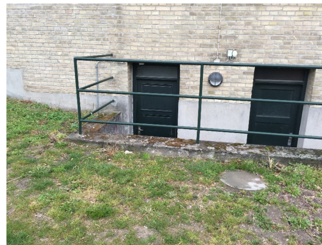
Døre til kælder er ældre trædøre
