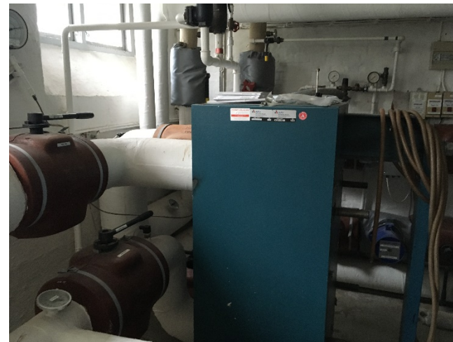
Varmevæksler i varmecentral Blok 7
