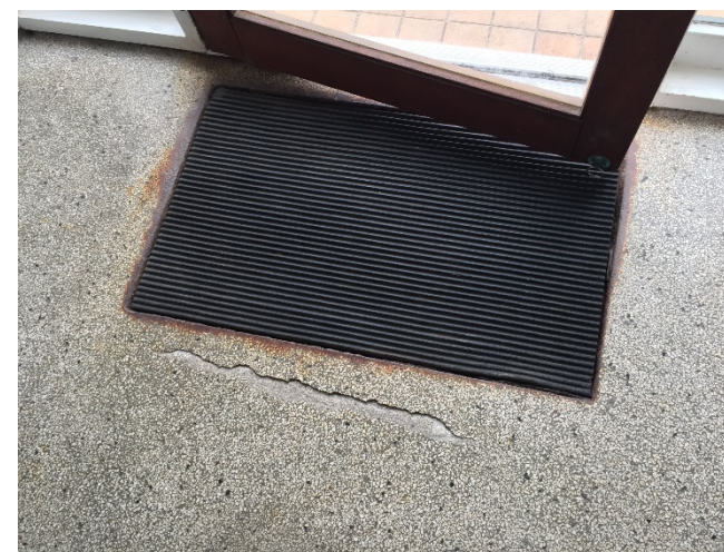
Skader på terrazzo ved indgangsparti
