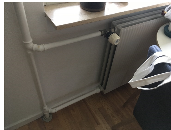
Radiator i bolig placeret under vindue
