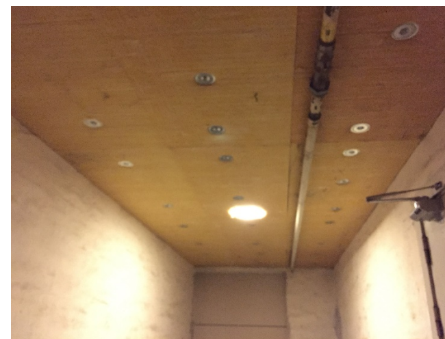
Enkelte steder er etageadskillelse mod kælder efterisoleret
