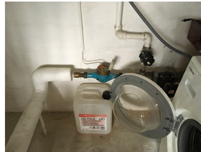
Bi-måler på koldt vandstilslutning til varmtvandsbeholder
