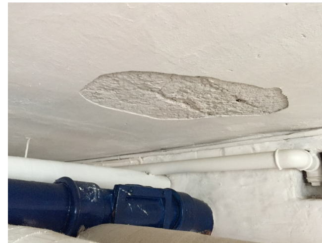
Mindre pudsafskalning i etageadskillelse mod kælder
