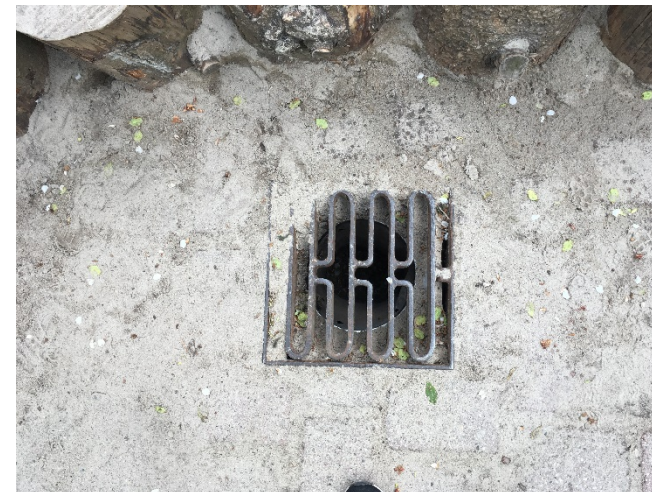
Overfladerist ved sandkasse på legeplads.
