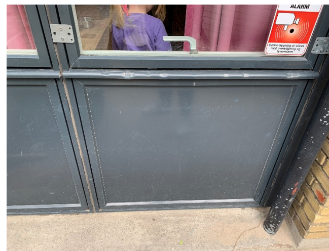
Vandnæser og fyldninger fremstår med en del slitage.
