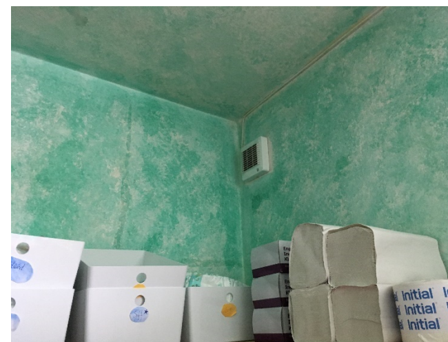
Mekanisk udsugning gennem facade.
