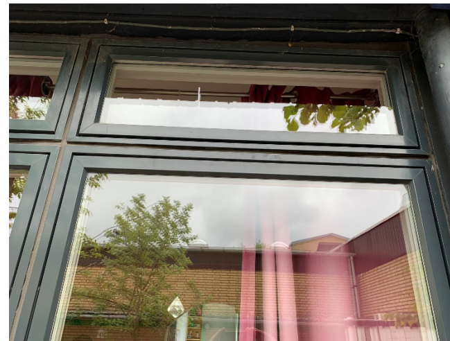
Vinduer er med udvendig overflade i aluminium.
