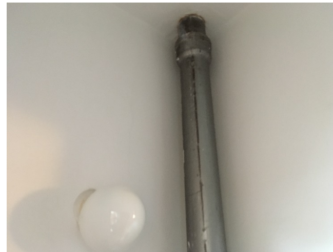
Faldstammeudluftning i toiletrum.
