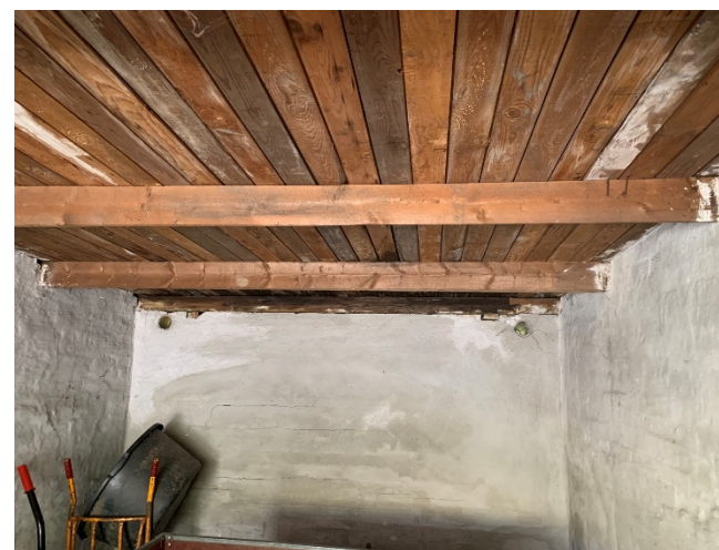
Underside af tag i garage. Træværk fremstår i god stand.
