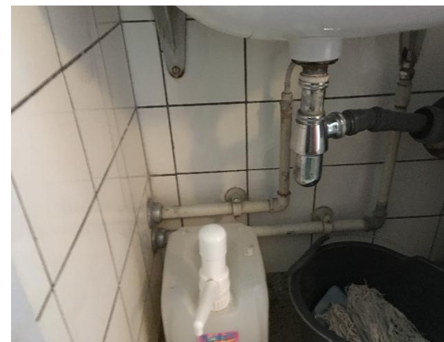
Synlig brugsvandsinstallation på væg under håndvask.
